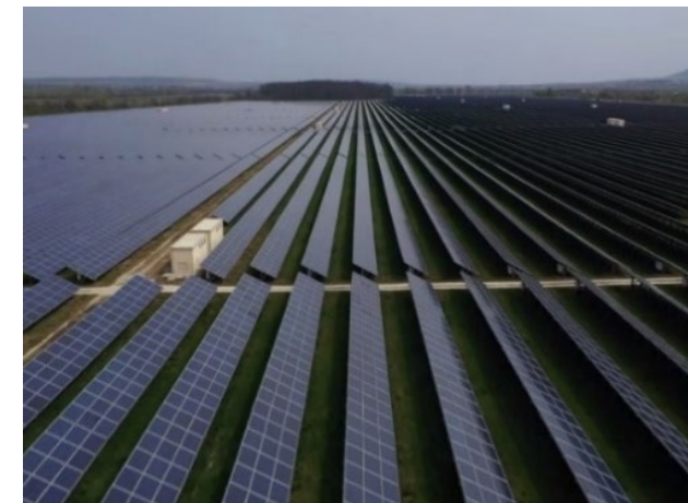
Photographie du parc photovoltaïque "Karad" - Bulgarie
